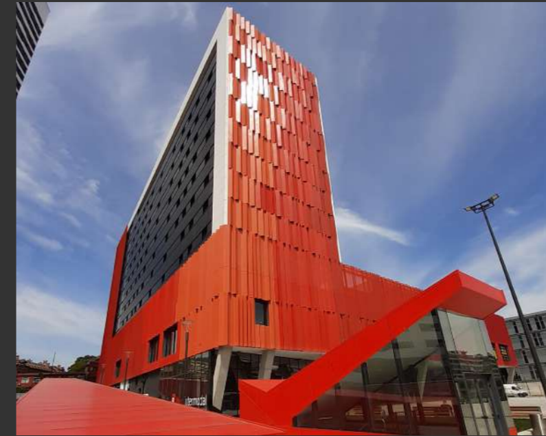
Intermodal Hotel & Residence, Bilbao (España)
