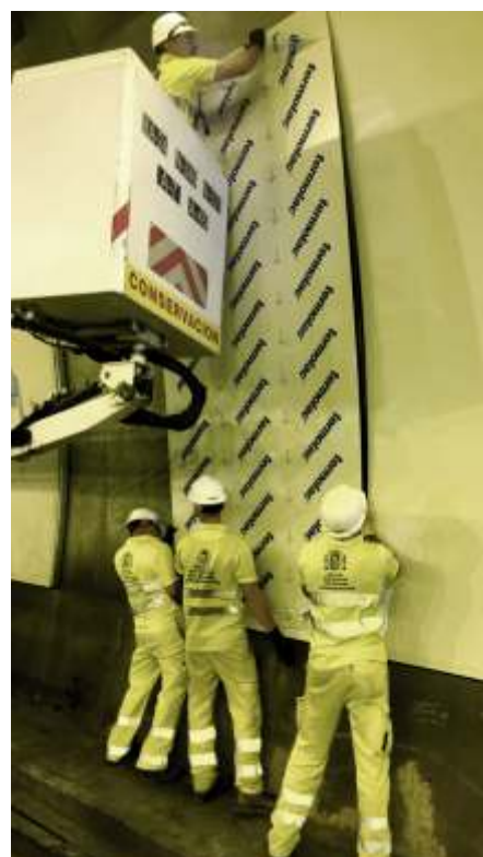
Forrado de tuneles
