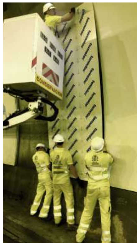
Forrado de tuneles
